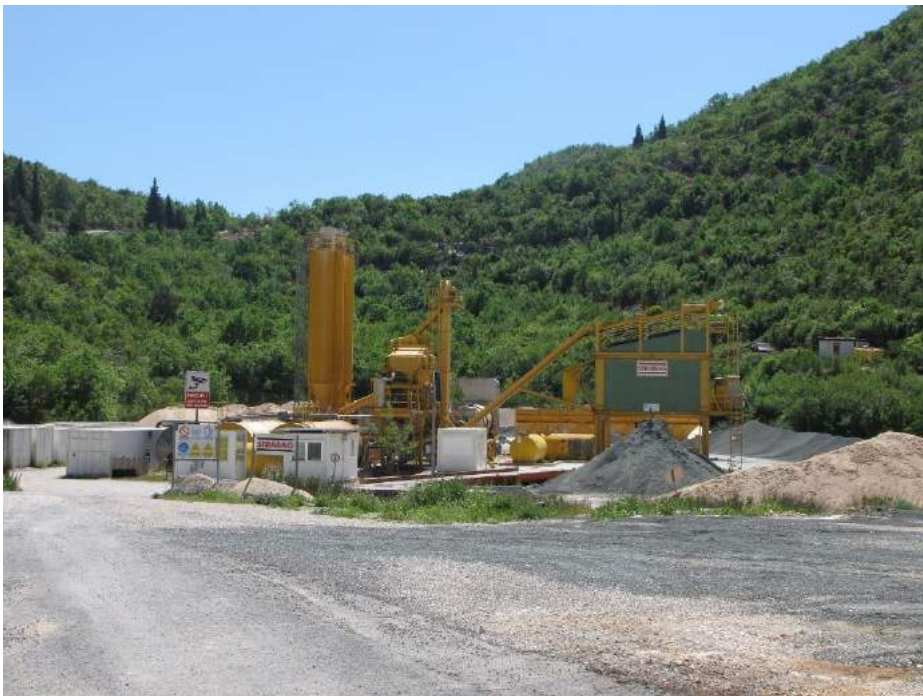
Slika 8. Postojeće stanje - Asfaltna baza
