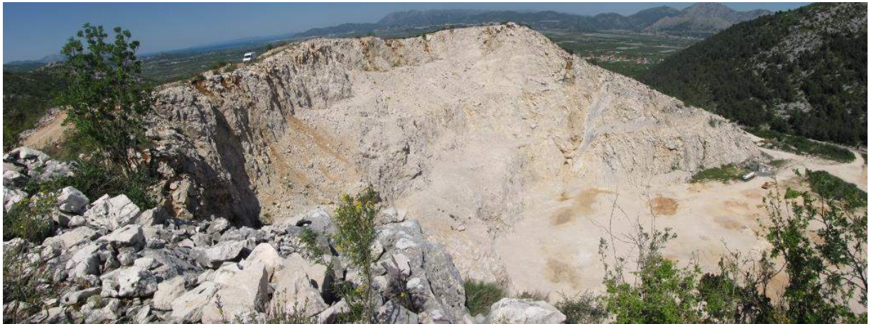
Slika 5. Postojeće stanje - formirane etaže
